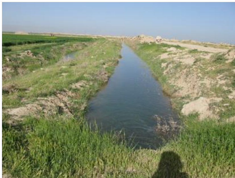
شکل ۱۳- استفاده از کانال بدون پوشش و نشت زیاد آب
