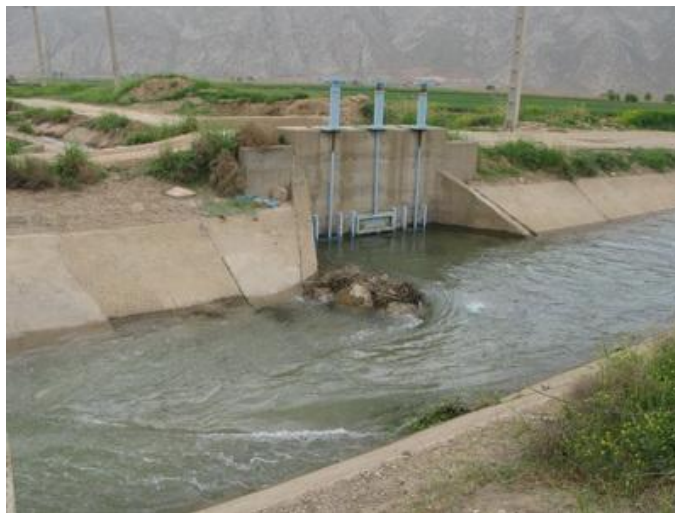
شکل ۸- نمایی از یکی از آبیگرهای کانال درجه ۳ در شبکه آبیاری درودزن (گذاشتن مانع در پایین دست دریچه)
