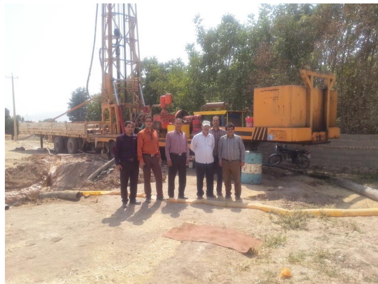
عملیات حفاری چاه روستای حسام آباد مرودشت به همت خیر بزرگوار آقای محمد رنجبر
